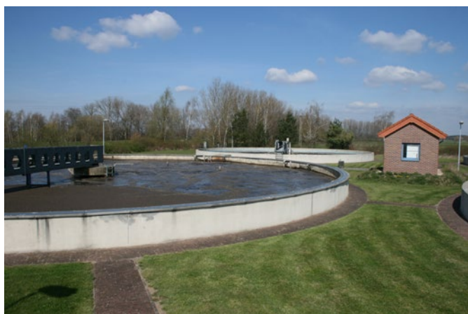
Abb. 2: Belebungsbecken mit dem Gebäude für Messtechnik
