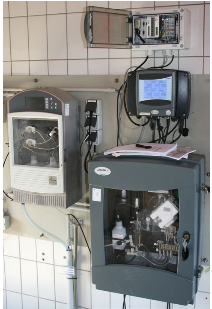
Abb. 3: Phosphax compact (links) mit SC1000 Controller und dem darüber installierten RTC-P-Modul.
